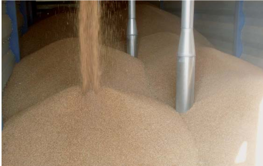
Рис 3: Загрузка склада (Засыпка примерно до середины всасывающей трубы.)
