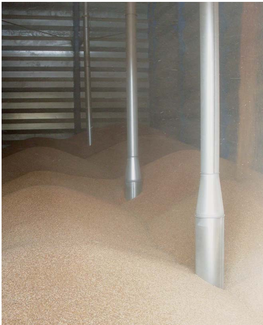
Figure 2 : situation de montage des trois tubes AIR-Pillar
